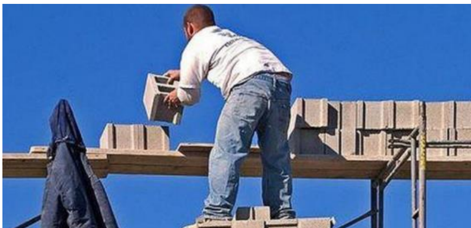
ภาพที่ ผ1-4 ตัวอย่างของการยกโดยที่วัสดุอยู่ห่างไกลตัว
